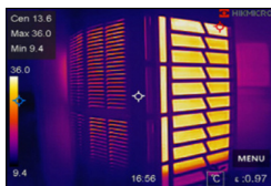
INSPECTION DES SYSTEMES DE CHAUFFAGE
