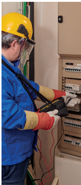
Contrôle d'une armoire électrique
